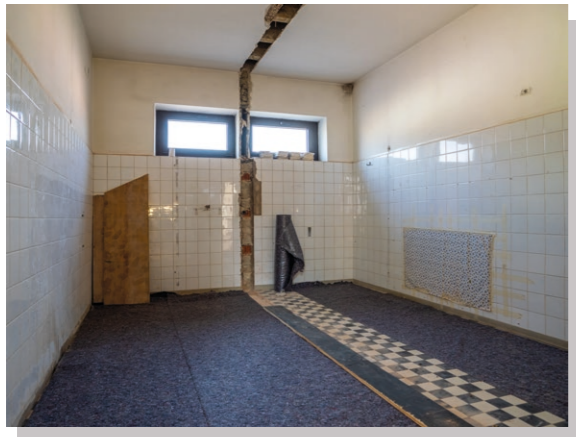
Umgestaltung der Toilettenräume
