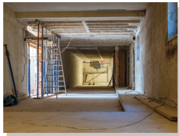
Aus Kegelbahn wird Bewegungsraum (2. Bauabschnitt)
