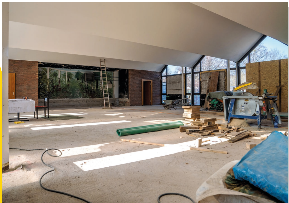
Bauarbeiten im großen Gemeindesaal
